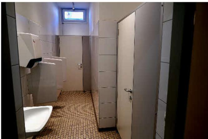
*Trennwände und sanitäre Einrichtungen wurden komplett erneuert. Durch den Umbau konnte ein Behinderten-WC in diesem Bereich geschaffen werden.*
