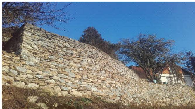
Schwergewicht Trockensteinmauer: 3,80 - 4,25 m hoch, 2 - 0,40 m dick, 34 m lang. Das ergibt 272 m<sup>2</sup> Mauer mit 270 m<sup>3</sup> Stein. 280 t Handleger, mit Hintermauerung weit über 500 t Stein insgesamt verlegt - in 1.200 Arbeitsstunden!
