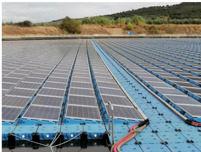
Die Solarpanele mit einer Größe von 1x2 m sind auf einem schwimmenden Gerüst befestigt.
