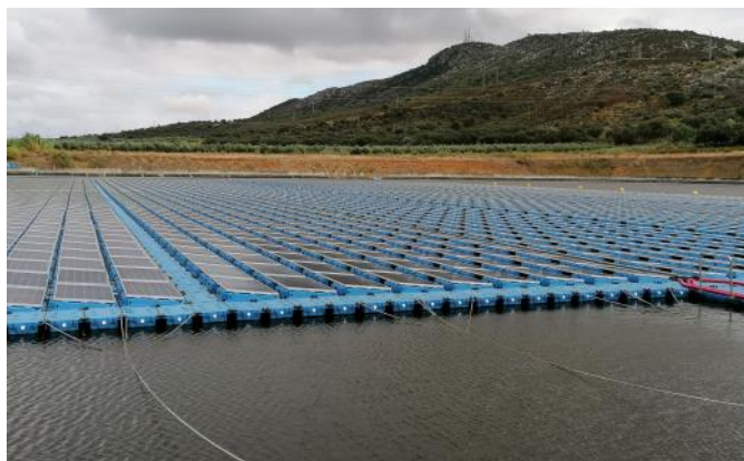
Die Solarpanele mit einer Größe von 1x2 m sind auf einem schwimmenden Gerüst befestigt.
